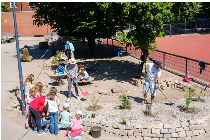
Die ersten Beete mit Trockenmauern entstehen.
